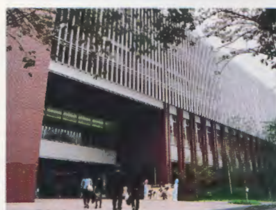
エスカレーターも設置された新校舎
