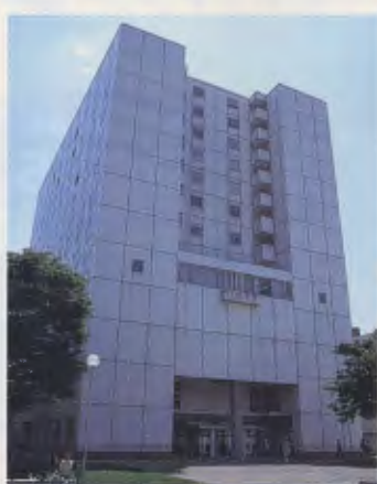
東2号館。法学部・経済学部教育研究棟
